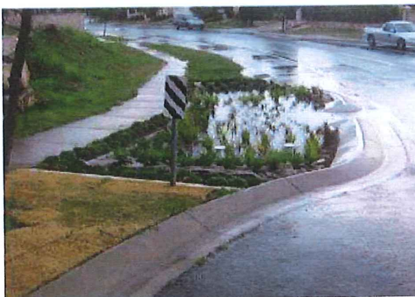
Ett exempel på s.k. Raingarden som tar hand om dagvatten invid gatan.
