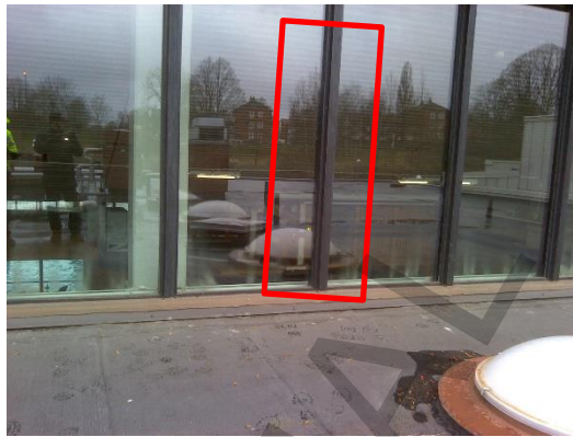
Foto 76, fasad, fönster med lös tätningslist, tydligt luftläckage vid fönsteranslutningar, (3). Flertalet fönster.
