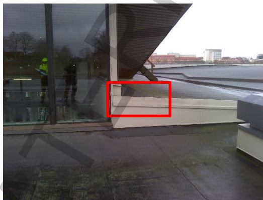
Foto 76, fasad, fönster med lös tätningslist, tydligt luftläckage vid fönsteranslutningar, (3). Flertalet fönster.
