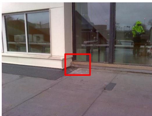
Foto 74, fasad, tydliga köldbryggor/luftläckage vid fönsteranslutningar, (3).
