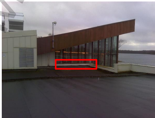
Foto 78, fasad, tydligt luftläckage/köldbrygga vid fönsteranslutningar, (3).
