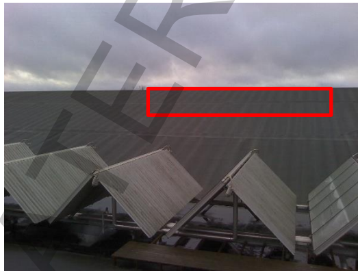
Foto 85, takplan, små temperaturdifferenser, möjligt luftläckage i takutsprång (1).
