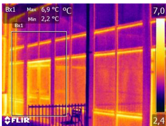
Foto 61, fasad, mindre temperaturdifferenser runt anslutningar, ingen anmärkning.
