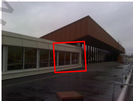
Foto 74, fasad, tydliga köldbryggor/luftläckage vid fönsteranslutningar, (3).
