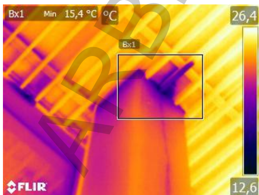
Foto 101, takkonstruktion, köldbrygga/luftläckage vid anslutning pelare, (3).
