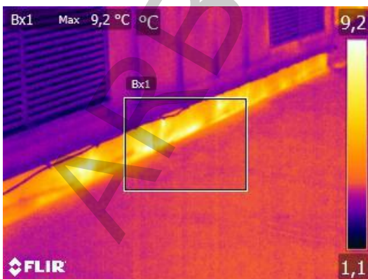
Foto 79, fasad, mindre temperaturdifferens runt anslutning, ingen anmärkning.
