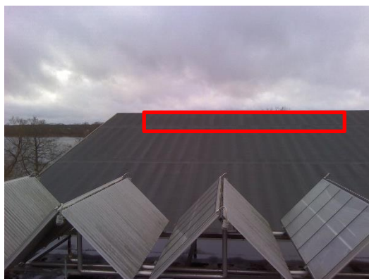
Foto 87, takplan, små temperaturdifferenser, möjligt luftläckage i takutsprång (1).
