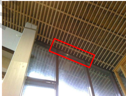
Foto 100, takkonstruktion, köldbrygga/luftläckage vid tak/väggvinkel, (3).
