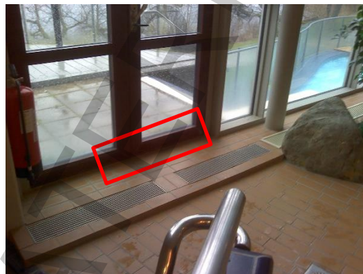
Foto 102, takkonstruktion, mindre köldbrygga/luftläckage vid pelaranslutning, (2).
