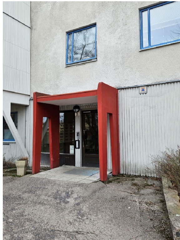
Entréportal i betong
